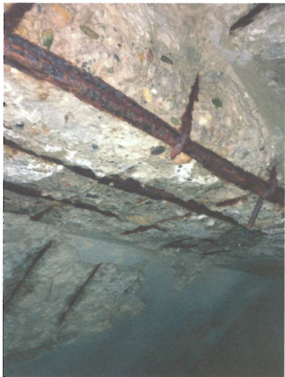
4.Încăperea zonă de acces. Armături corodate și tencuieli degradate.
